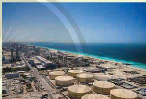
Hình 6.1. Nhà máy khử mặn nước biển Re-bi A-li (Jebel Ali – Các Tiểu vương quốc A-rập Thống Nhất)
