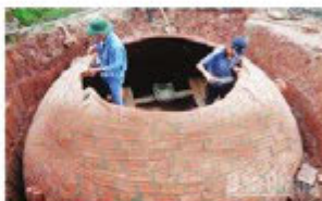
Hình 2.9. Hầm biogas xây bằng gạch
