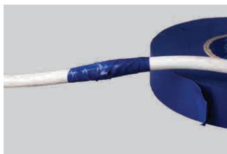
d) Kiểm tra, bọc kín chỗ cách điện bị hỏng trên vỏ dây dẫn
