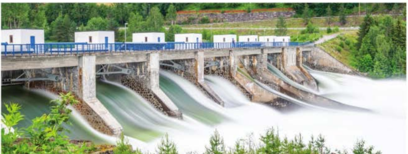
Hình 12.5. Nhà máy thủy điện
