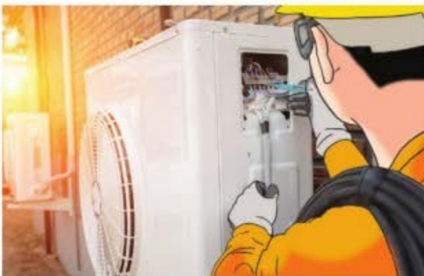
a) Sửa chữa điện máy điều hoà không khí
