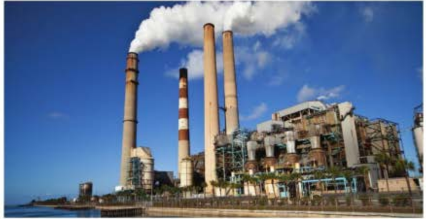
Hình 12.6. Nhà máy nhiệt điện
