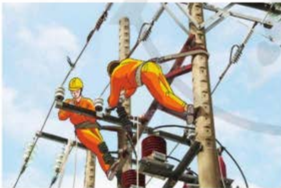
a) Sửa chữa đường dây điện
