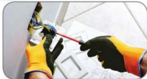
Hình 11.2. Sửa chữa mạch điện
