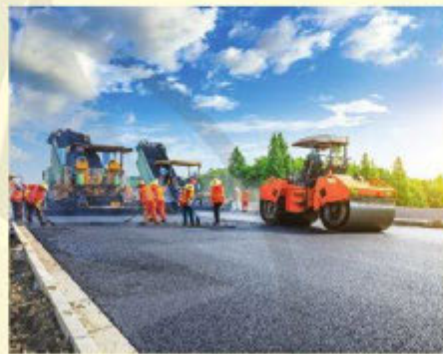
d) Máy thi công đường bộ
