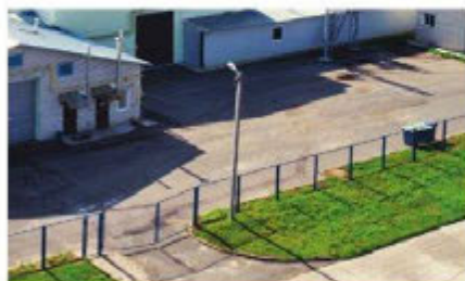
Hình 18.11. Hệ thống hàng rào bảo vệ
