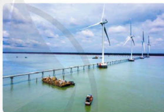
Hình 4. Các trụ điện gió tại Nhà máy Điện gió Đông Hải 1 (huyện Duyên Hải, tỉnh Trà Vinh)
