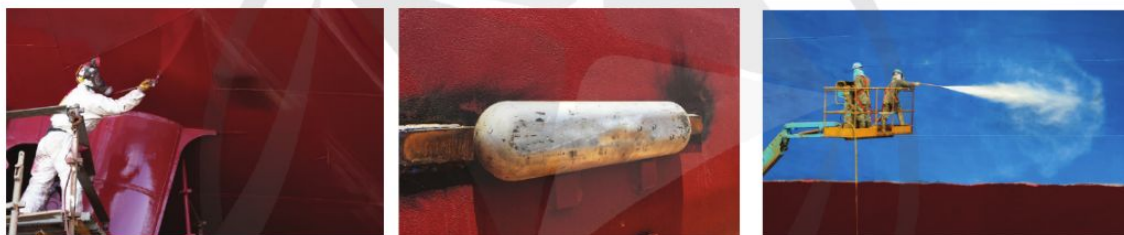
Hình 16.1. Các công đoạn hoàn thiện vỏ tàu bằng thép
