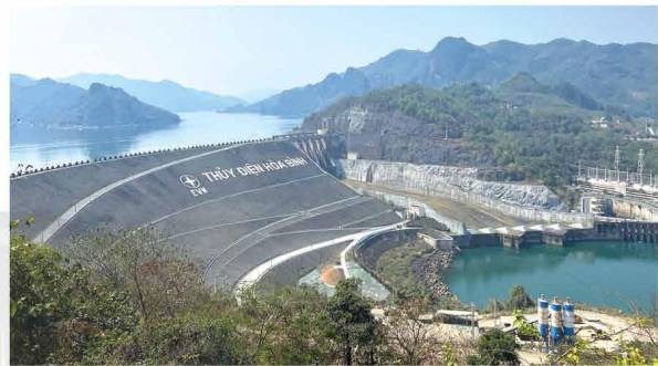
▲ Hình 13.1. Nhà máy thủy điện Hoà Bình
