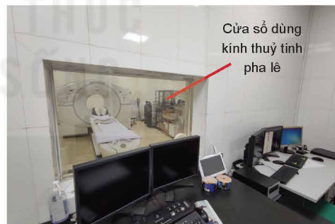
Hình 23.13. Thủy tinh pha lê được lắp tại nơi làm việc có nguồn phóng xạ
