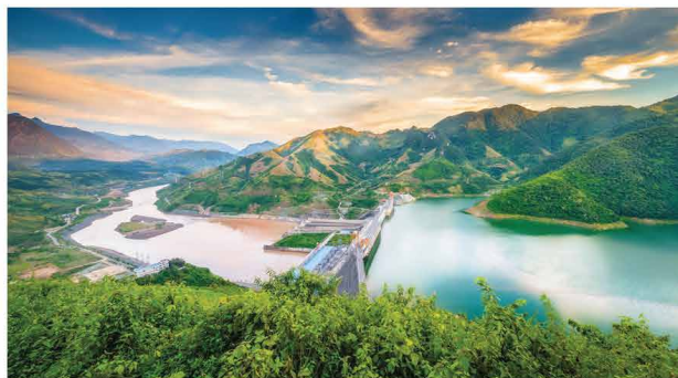
Hình 2.2. Nhà máy thuỷ điện Sơn La (Sơn La)
